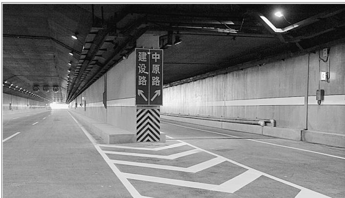
沙快速通道隧道和高架桥设计使用寿命均为100年。这里指的是主体支撑和重要结构部分,不包括路面的铺设和非主体结构。
