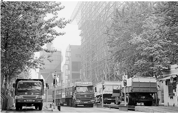
荥阳投资1.22亿,再建一条城市生活垃圾处理线。新生产线在我省唯一的垃圾发电厂郑州荥锦绿色环保能源有限公司,每日处理垃圾能力设计为600吨,一年就能处理19.8万吨,几乎全部用于处理郑州市区的生活垃圾,预计每年新增发电量1.368亿千瓦时。新的垃圾发电厂最大亮点是利用水泥回转窑焚烧垃圾,不会产生有毒气体。建成后,郑州城区2/3的生活垃圾都能变害为宝。本报记者 陈靖 摄
