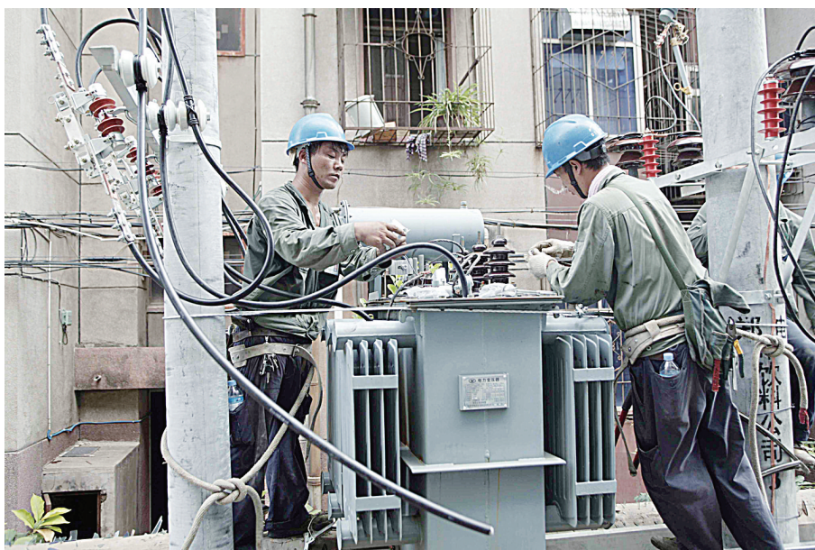
迎峰度夏更换变压器
