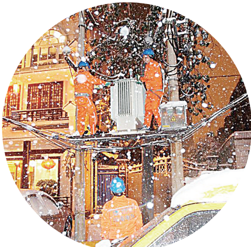
迎峰度冬电力抢修
