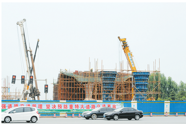
东四环跨金水东路立交桥正在加紧施工,预计年底前通车。
