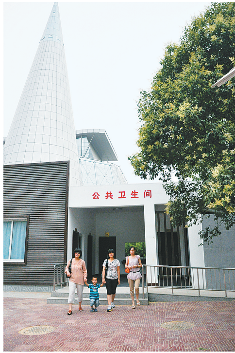
日前,绿城广场西游园新规划建设的公厕正式投入使用。公厕位于西游园南侧,外墙颜色古朴优雅,由专业人员进行设计并参照国家二类公厕标准建设,建筑面积达83.1平方米,为前来晨练、休闲的市民提供更多的方便。 本报记者 汪静文 摄
