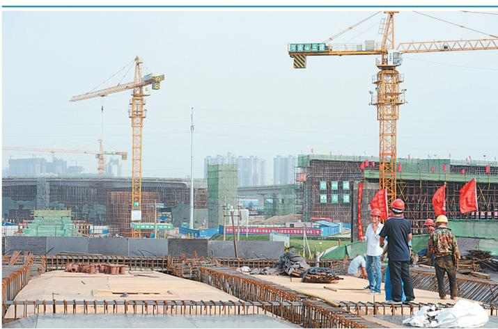
本报讯(记者 黄永东 文唐强图)郑州市航海路快速化改造重要节点性工程——西三环航海路立交主体工程已经过半,东西方向航海路有望年底通车。据介绍,整个工程共需建设桩基994根,目前已完成965根;桥墩承台总计229个,已完成203个;墩柱总计226个已完成179个;桥体箱梁共58联,已完成9联。
