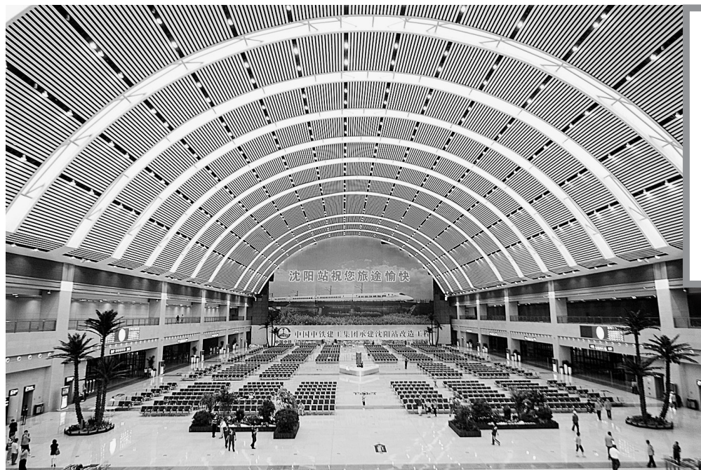
这是即将投入使用的沈阳站高架候车室。
