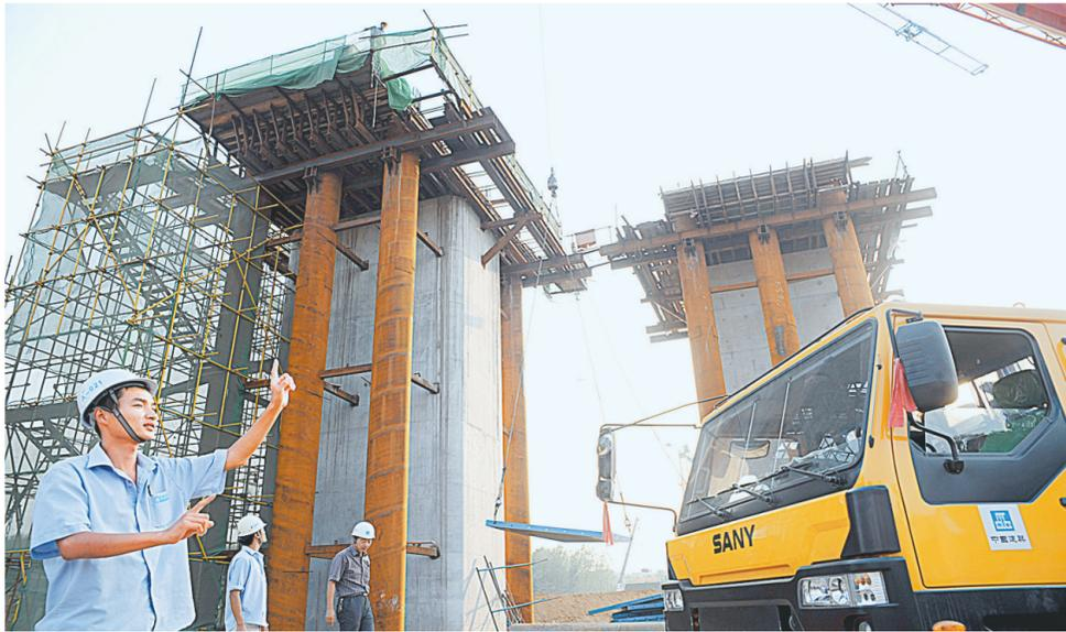
昨日,记者在市建委承建的13座跨南水北调桥项目工地上,看到工人们正在加紧施工抢工期,以确保在南水北调干渠工程竣工之前完成这些桥梁的主体建设。图为规划中的颍渡路高架快速通道跨南水北调特大桥施工现场,目前干渠内8个桥梁主墩都已完成,工人们正开始进行墩柱上方的挂篮施工准备。
