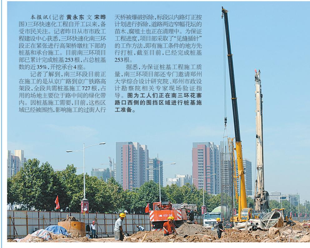
本报讯(记者 黄永东 文 宋晔图)三环快速化工程自开工以来,备受市民关注。记者昨日从市市政工程建设中心获悉,三环快速化南三环段正在紧张进行高架桥墩柱下部的桩基和承台施工。目前南三环项目已累计完成桩基253根,占总桩基数的近35%,开挖承台4座。
