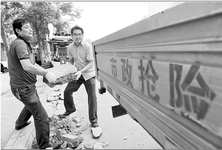
连日来,惠济区城市管理执法局对辖区主干道开展大规模清障活动,将沿线单位私设的水泥爬坡、铁架子爬坡全部拆除,消除道路交通安全隐患。本报记者 李利强 摄
