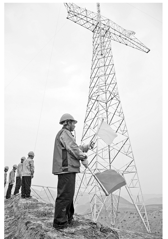
21日,哈密南至郑州±800千伏特高压工程宁夏标段首座铁塔架线成功。该工程全长2210公里,预计2014年建成投运。建成后每年输电480亿千瓦时,转化煤炭2000万吨以上,是我国“西电东送”战略的关键线路之一。新华社发
