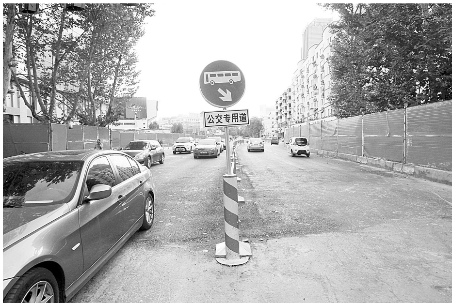
昨日,随着地铁一号线工程初步完工,人民路丹尼斯门前施工围挡已拆除完毕,路面恢复基本通行。但由于地铁出口未全部完工,由北向南依然只许公交通行。本报记者 宋晔摄
