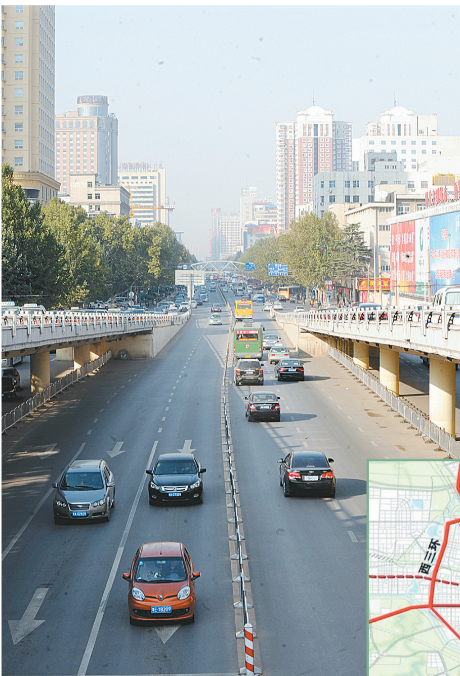
金水路与花园路立交分散了车流。
