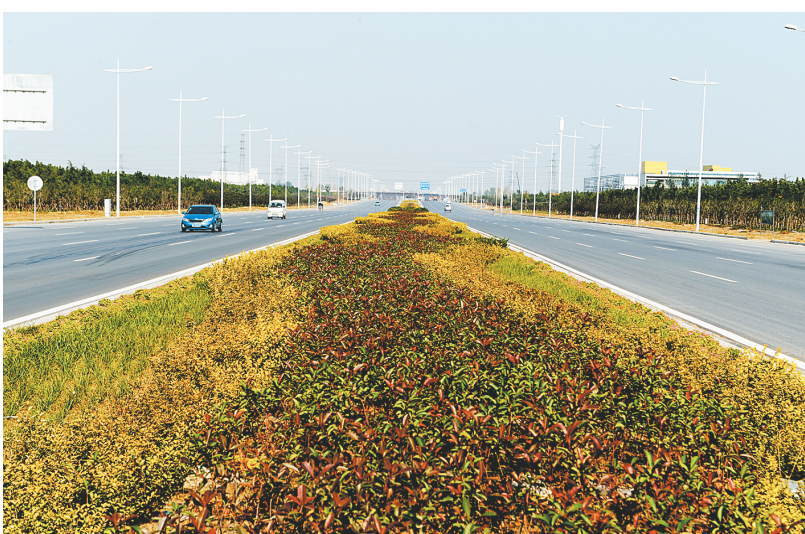
城乡路网建设促进了城乡一体化进程。
