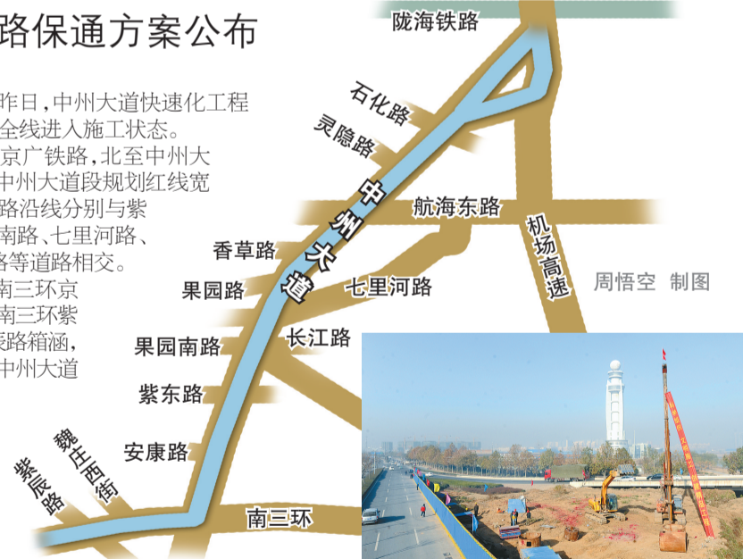
中州大道快速化工程开工钻
