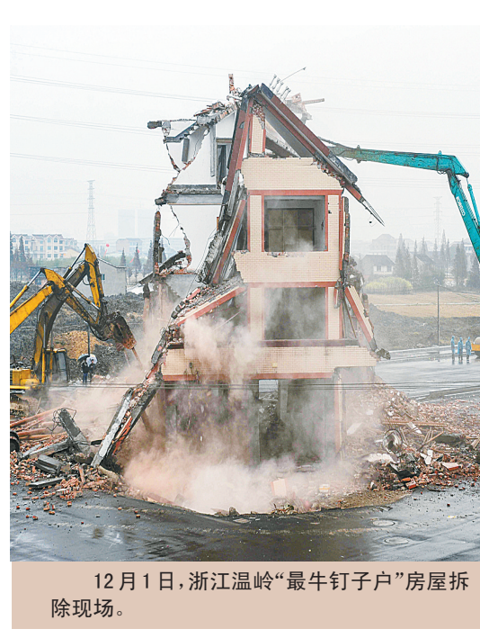
12月1日，浙江温岭“最牛钉子户”房屋拆除现场。
