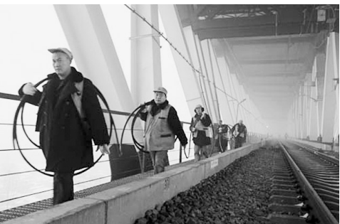
近日,郑州桥工段职工精心检查、养护京广高铁线路设备,确保12月26日京广高铁京郑段顺利开通。图为该段职工对郑州黄河公铁两用桥进行检查。 本报记者 张丽霞 摄
