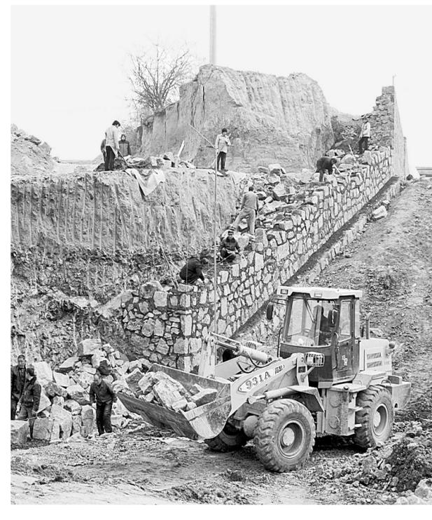
本报讯(记者 史治国 通讯员 王海琴 文/图)记者在荥阳市刘河镇王河水库南侧除险加固工程现场看到，挖土机快速清理土石，运输车往来穿梭运送石料，几十名水利工作人员正在大坝上浆砌护坡(如图)。像这样的冬修水利场面，在荥阳市乡镇随处可见。目前，农田灌溉机井升级改造、小型农田水利工程、农村饮水安全村村通自来水工程、河道综合治理等工作在城乡全线展开。荥阳境内有四座中型水库和多条河流。“经过努力争取，荥阳境内的13座中小型水库除险加固工程、3条河道治理工程全部争取到国家计划，枯河、索河、汜水河同时开工治理，这在荥阳历史上尚属首次。”置身水务，荥阳市水务局局长张振海倍感欣慰。近日，荥阳索河楚楼水库至荥广公路段河道治理工程全面启动。目前，荥阳境内三条河流一期治理工程正热火朝天进行中，年底前将完成主体工程。据了解，今冬明春，荥阳计划投入资金1.77亿元，新增有效灌溉面积9040亩，旱涝保收田面积1000亩，节水灌溉面积7000亩，新打灌溉机井106眼，更新改造农田灌溉机井800眼。目前，各项建设工程在全市9个乡镇111个行政村全面开工。
