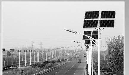
郑新快速通道两侧安装了太阳能路灯,降低了后期成本。
