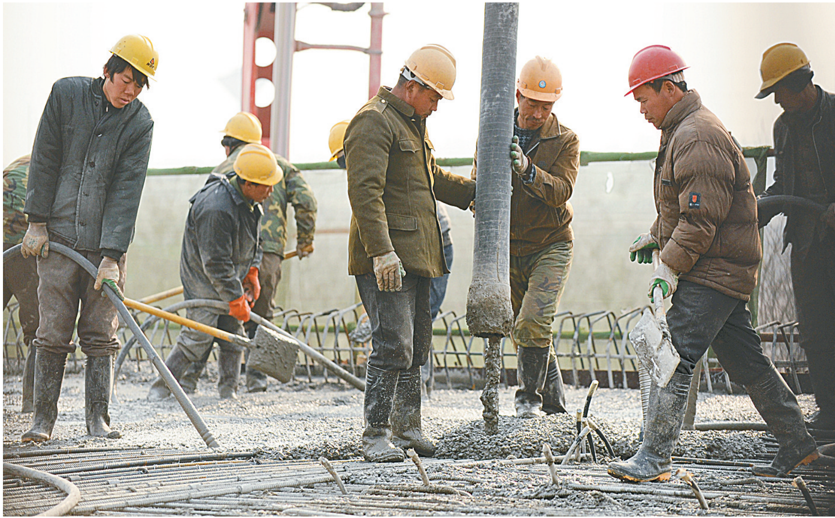
三环快速化工程建设者浇筑桥体箱梁。 本报记者 宋晔 摄
