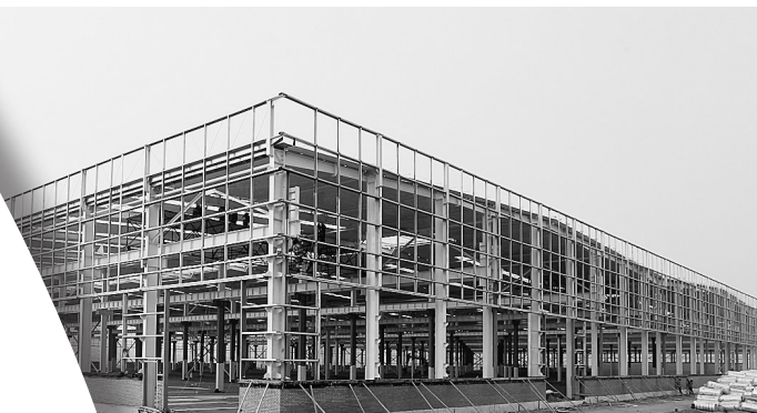
河南吉祥铝业有限公司钢构车间主体已经建成。
