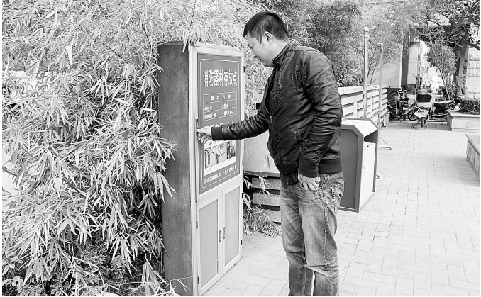
杨磊在社区检查消防设施。
