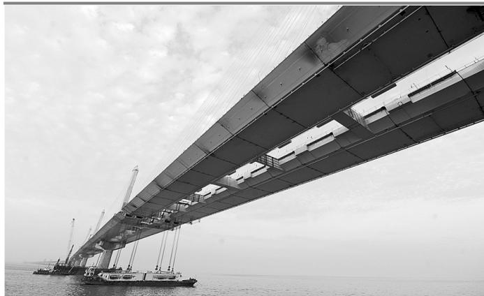
2月3日,随着四台桥面吊机缓缓起升,嘉绍跨海大桥最后两片钢箱梁从水面顺利起吊至40米高的桥面,这也标志全桥的箱梁吊装全部完成。
