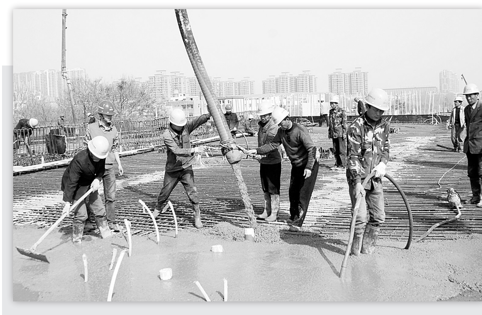
郑州三环路快速化工程大部分桩基和承台建设完成,全面进入高架混凝土箱梁施工阶段。昨日,中水电第七工程处成功浇筑西三环标段第九联混凝土箱梁,这是该工程春节后浇筑完成的首个大型箱梁。本报记者 宋晔 通讯员 胡鹏 摄
