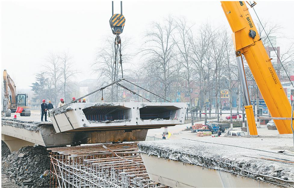
本报讯(记者 刘招 通讯员 席湘平 文/图)昨日,中原路跨线桥开始拆除。据了解,本次拆除采取的绳锯切割,大大降低了污染和噪音,在我市尚属首次。
