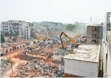
虽然这里满目废墟，但很快就会建起现代化的崭新建筑。图为高新区沟赵办事处祥营村拆迁工作现场。
