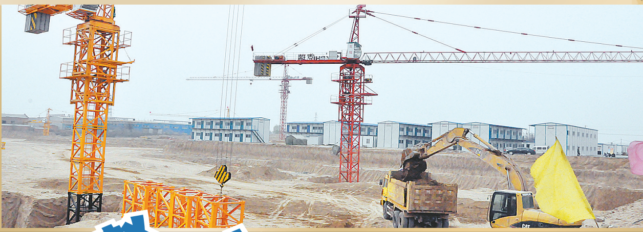
“高新·锦和苑”安置房建设现场
