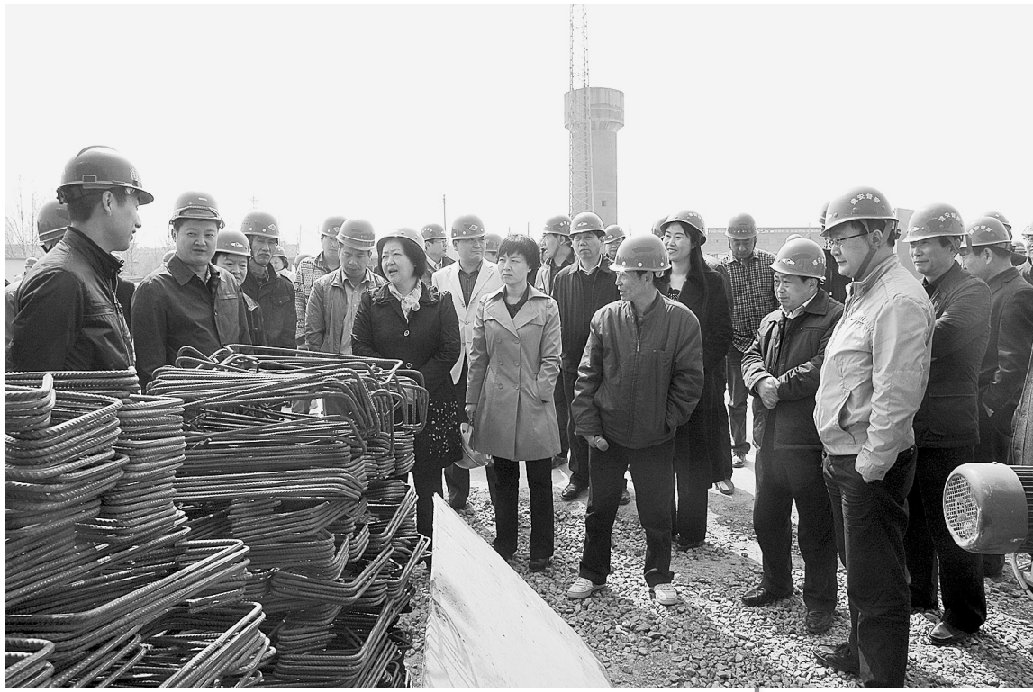
近日,市人大常委会组织代表到荥阳市新型农村社区施工现场开展集中视察活动,就群众关心的进场企业资质审查、质量安全、村民监督小组职责履行等情况进行现场调研,并就如何确保工程顺利推进向建设单位提出建议和意见。本报记者 李娜 通讯员 洪斌摄
