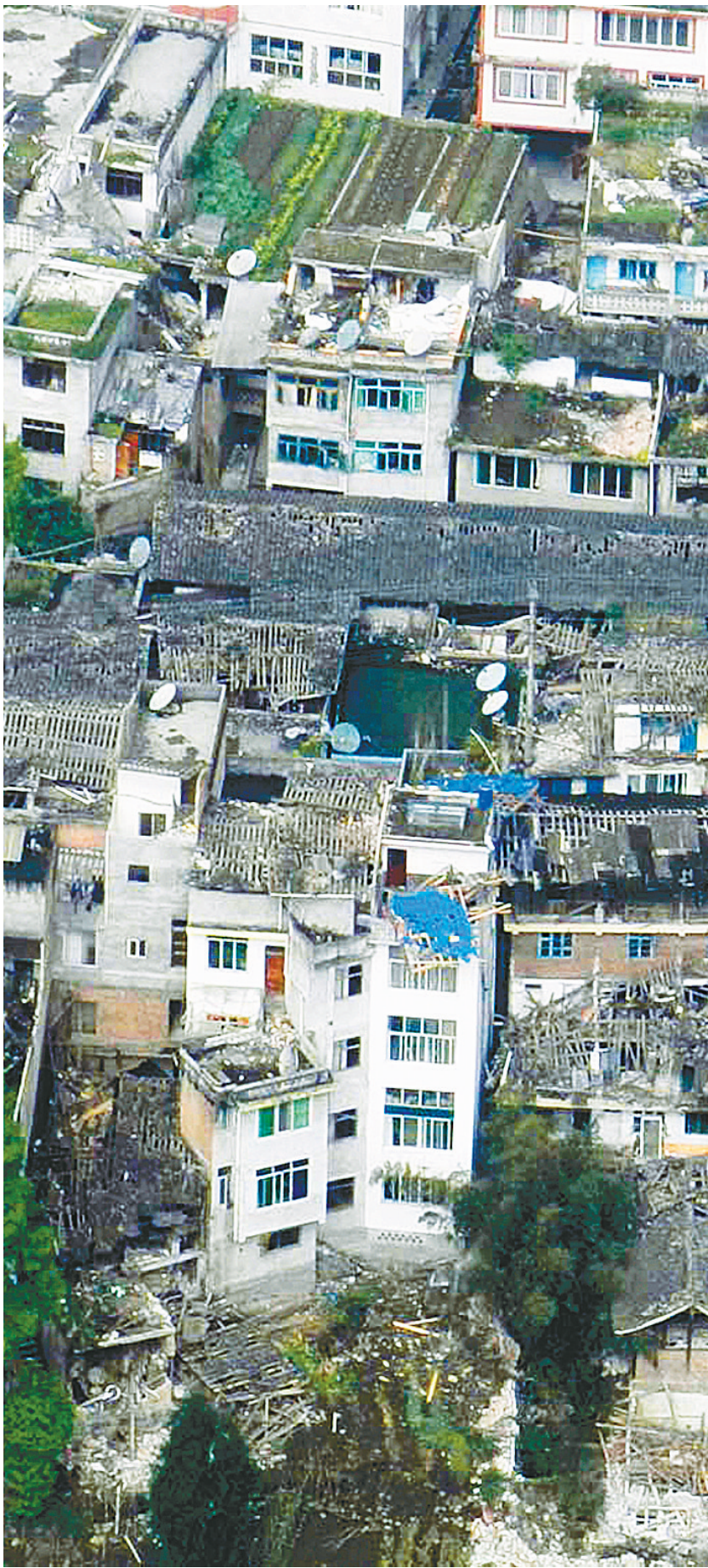
在直升机上拍摄的四川省芦山县太平镇地震灾区倒塌受损的房屋。新华社发
