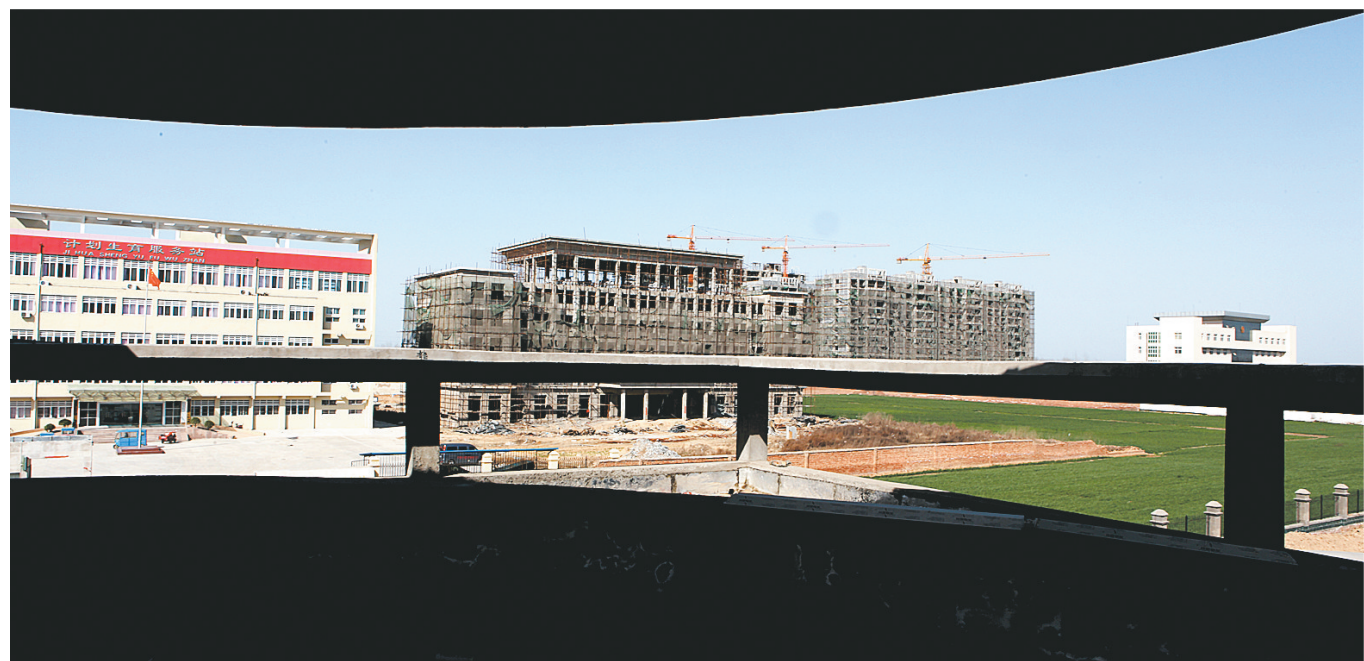
正在建设中的尉氏产业集聚区。
