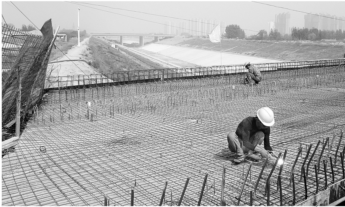
嵩山路跨南北水调运河大桥正在紧张施工,预计5月底全部通车。该工程去年6月开工,桥长155米,双向八车道。 本报记者 安群英 通讯员 张建华 摄
