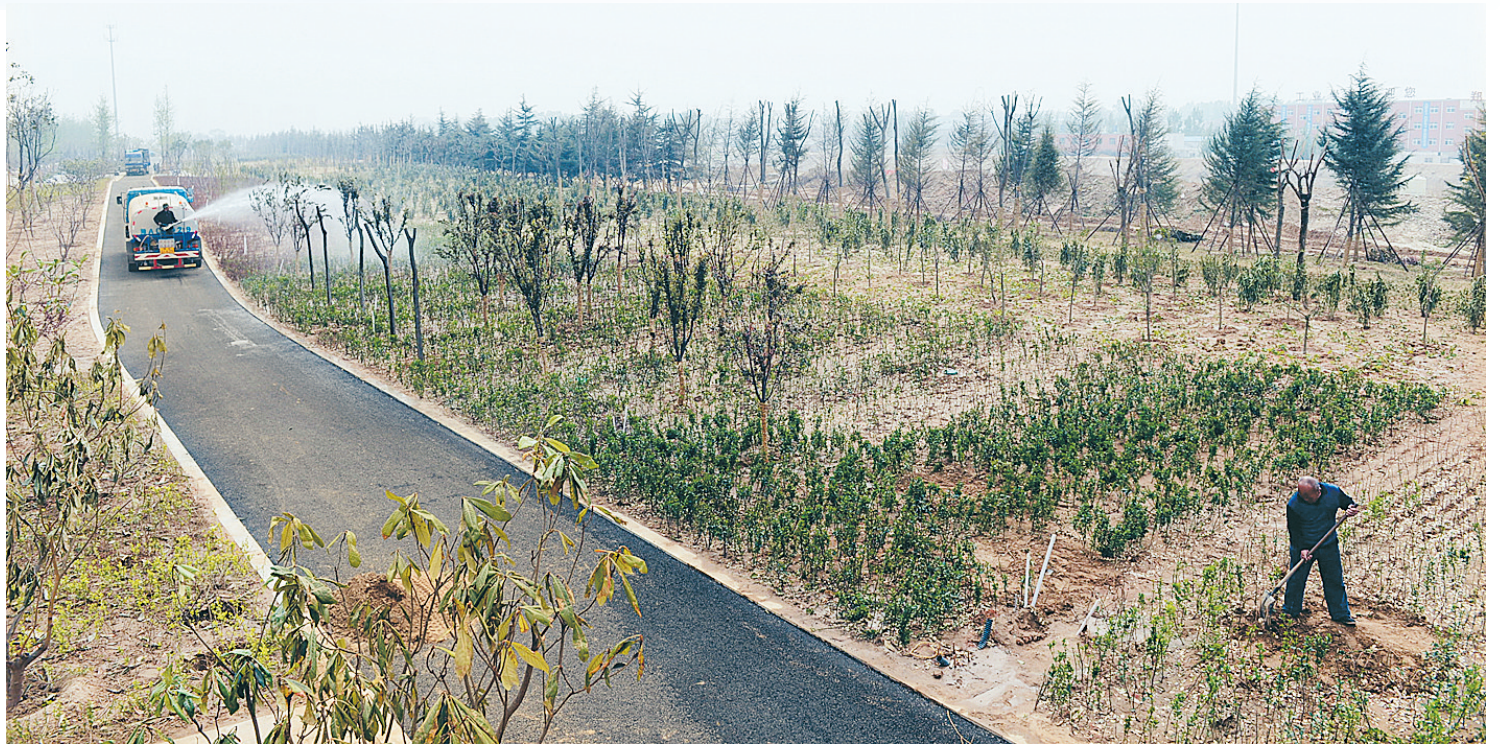
施工人员正在精心养护绿色长廊。
