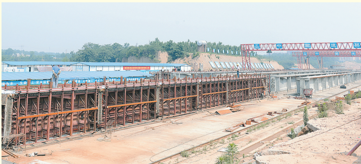
郑州至上街快速通道工程建设现场
