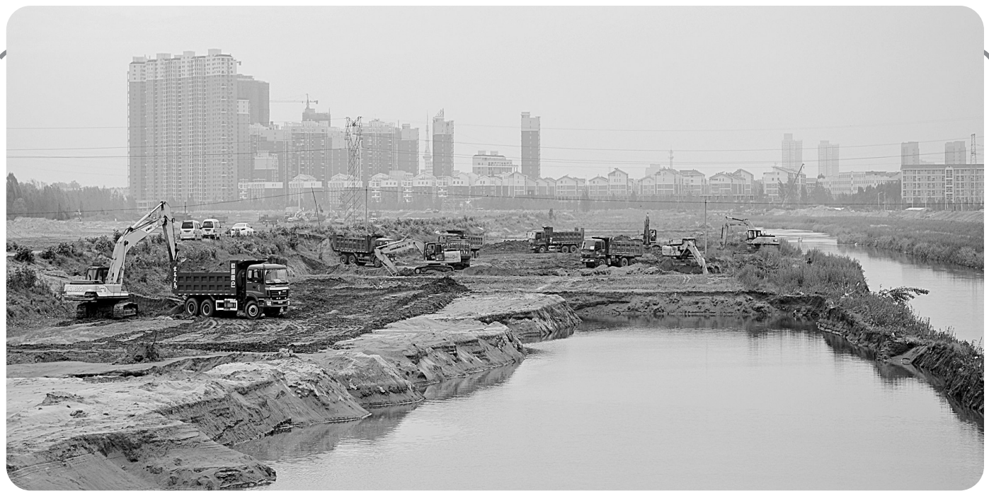
258台机械昼夜施工
