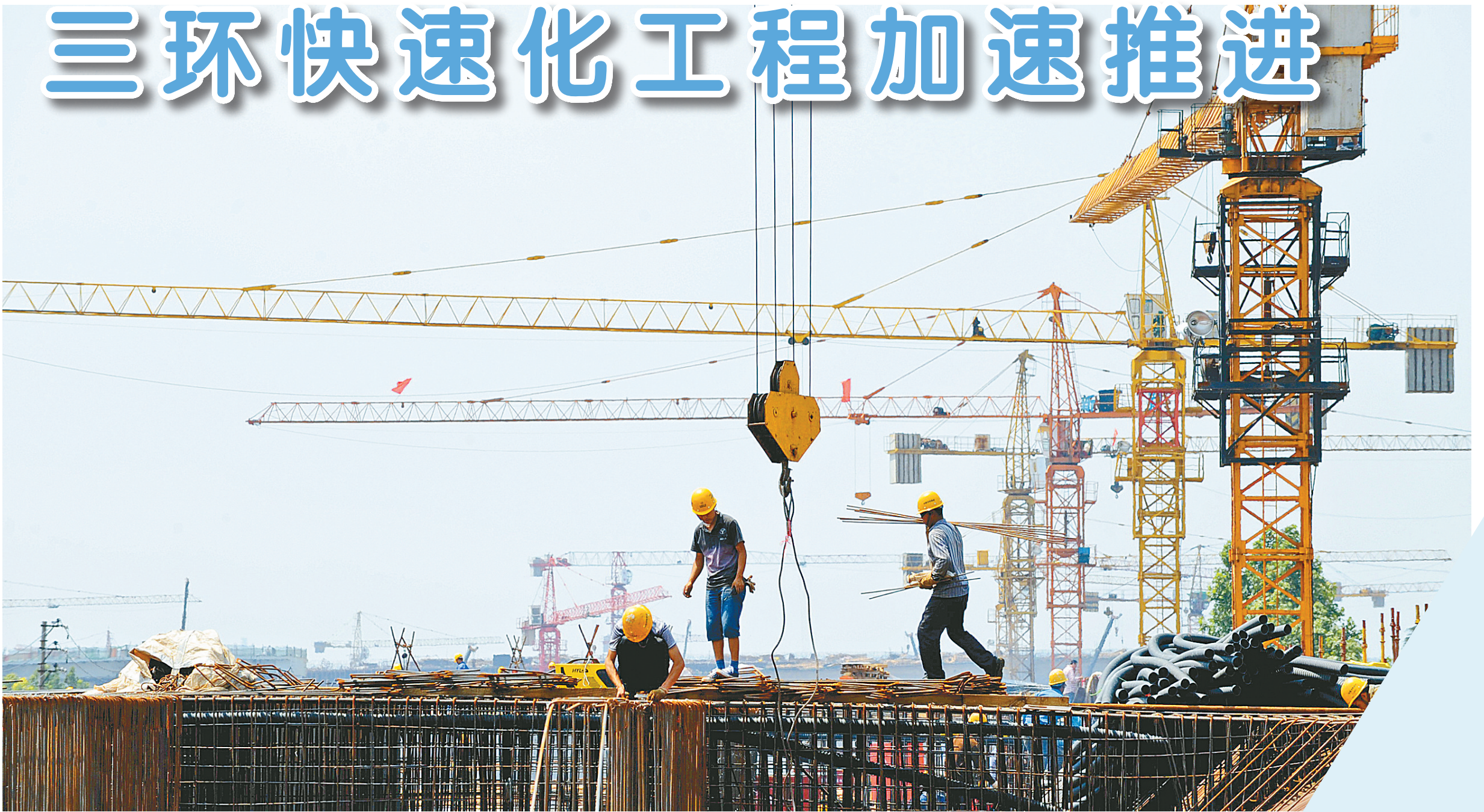
倒排工期,各施工单位通力合作,加快工程推进。
