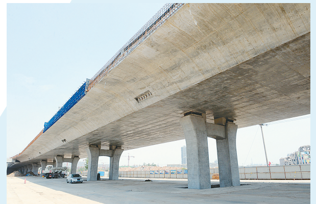
部分路段高架主体基本完工。
