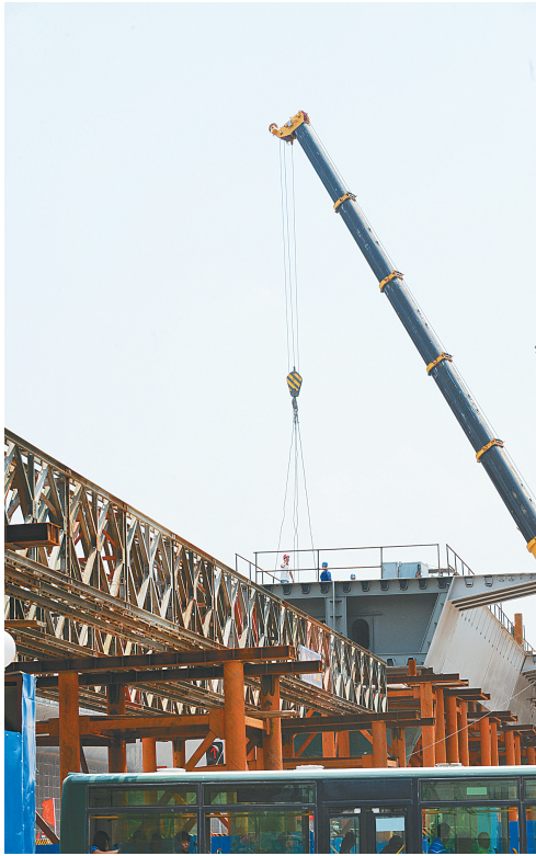
北环路段采用整体钢梁吊装保障车辆通行。
