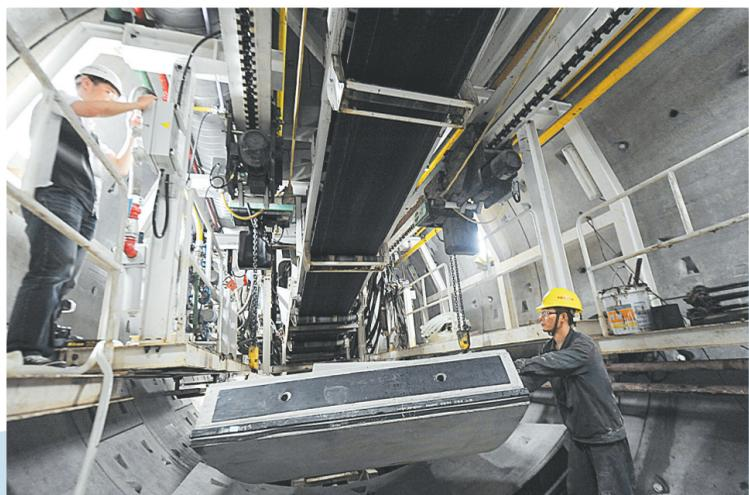
地铁施工人员安装管片。
