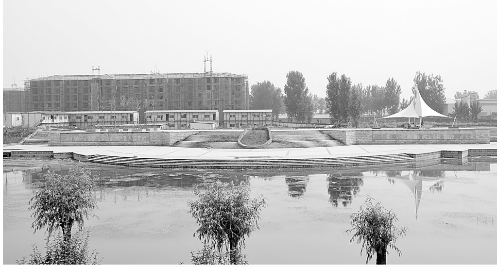
公园工程主体已完工。
