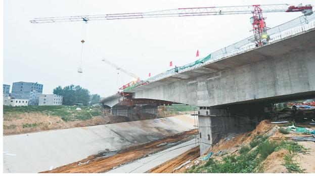
本报讯(记者 黄永东 宋晔 图)昨晚,跨南水北调总干渠上一座长238米特大桥——豫一路南水北调桥顺利合龙。豫一路南水北调桥去年8月开工,设计全长约653米,其中桥梁跨度长约238米,剩余长度为两侧引桥。桥面总宽度50米,除两边各3.5米宽的人行道外,桥中间路面双向8车道,设计时速为60公里。由于桥下南水北调干渠也正在施工,为避免对干渠施工造成过大影响,该桥在建设过程中采取了悬臂挂篮施工工艺,昨晚悬空的桥体在干渠上空成功实现“握手”,比计划工期提前了两个月。
