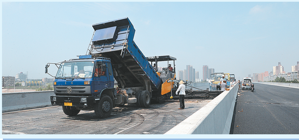
昨日,三环快速路南环段高架主线道路开始铺沥青。为加快三环快速路建设,各施工单位科学安排,穿插施工,加快施工进度,力争早日建成通车。本报记者 许大桥 摄
