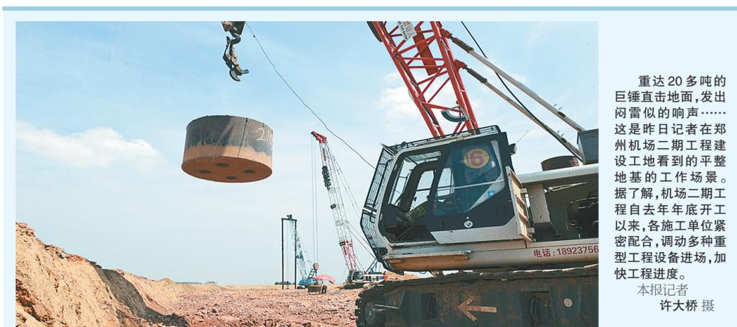
重达20多吨的巨锤直击地面,发出闷雷似的响声……这是昨日记者在郑州机场二期工程建设工地看到的平整地基的工作场景。据了解,机场二期工程自去年年底开工以来,各施工单位紧密配合,调动多种重型工程设备进场,加快工程进度。
