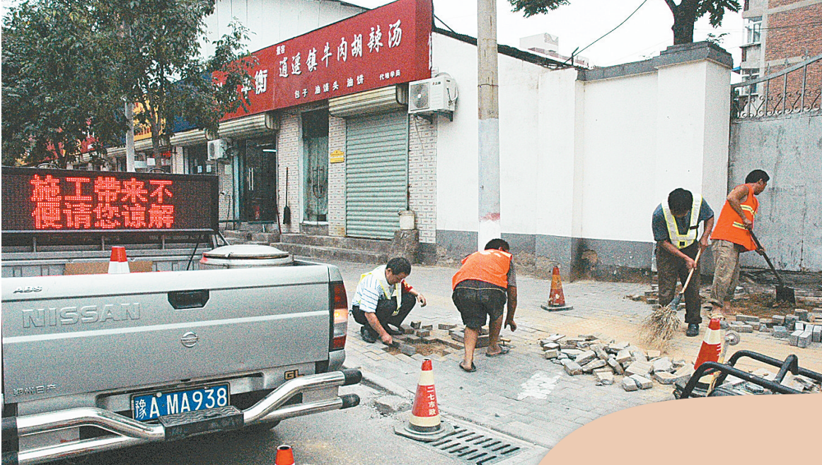
按照创文迎检要求,二七市政所重点对迎检道路及学校、商场等迎检点周边道路进行整治。截至目前共对淮南街、政通路等迎检道路完成人行道整治58平方米、车行道整治388平方米、清理道路障碍物34处、维修窨井2座。本报记者 赵文静 摄
