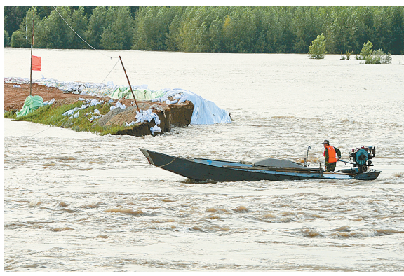
23日8点20分左右,巡护员发现黑龙江堤坝同江市八岔乡段出现一个十多厘米的管涌,十多分钟后堤坝已被冲开20米,截至14时决口已超过200米。图为8月23日,一艘搜救艇穿越堤坝决口进入村中巡查。
