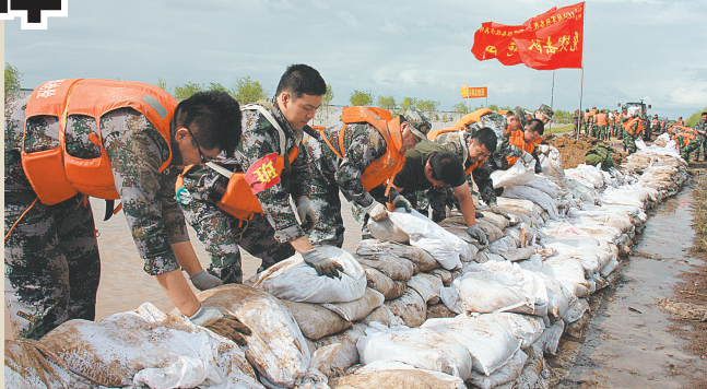
黑龙江预备役步兵师高炮团官兵在同江市同抚大堤三村镇二村段加固,构筑子堤。黑龙江的又一次洪峰将于8月26日左右到达佳木斯市同江至抚远江段,沈阳军区日前已出动现役官兵和民兵预备役人员10200余人迎战洪峰。 新华社发
