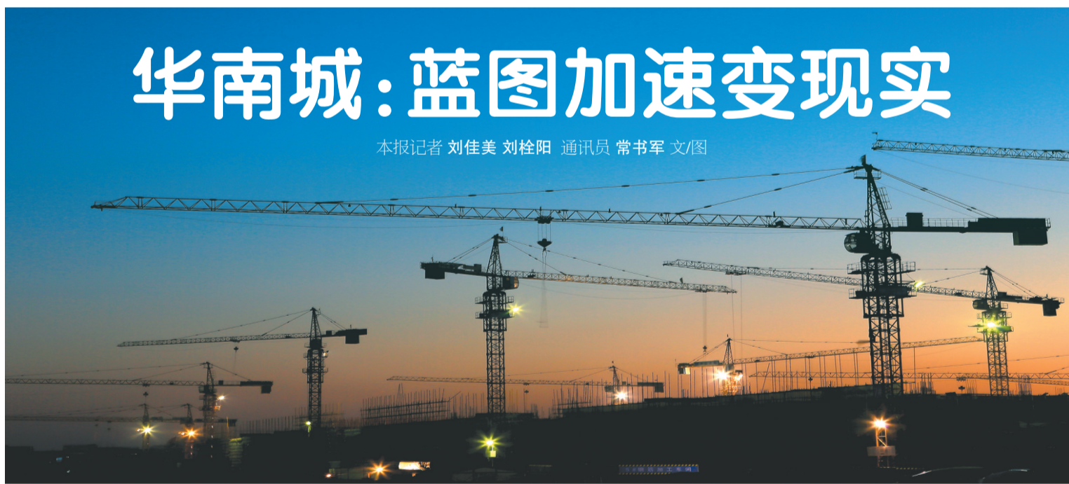
傍晚时分,暮色苍茫,但华南城建设工地依然一片繁忙。
