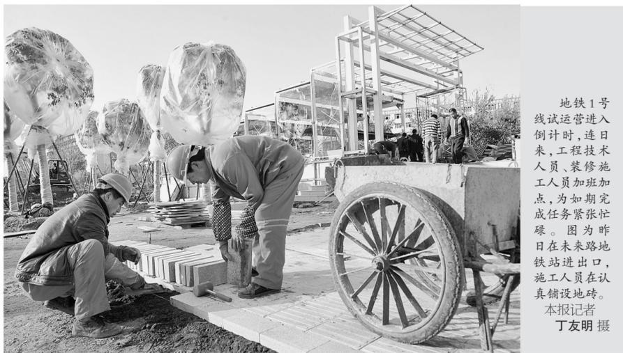
地铁1号线运营进入倒计时,连日来,工程施工人员加班加点,为如期完成任务紧张忙碌。图为昨日在地铁1号线施工现场,施工人员正在认真铺设地砖。
