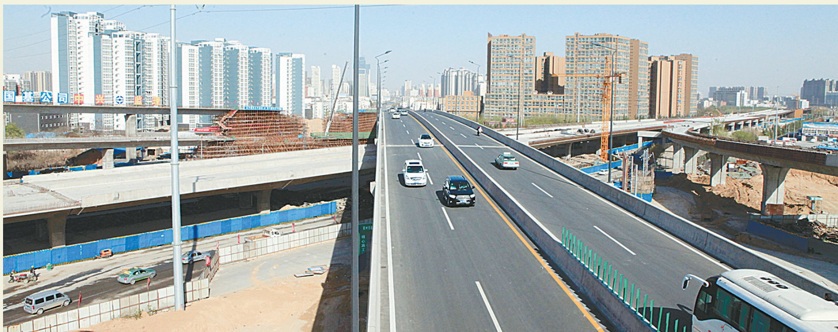
西三环航海路互通立交工程。
