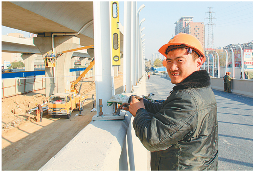
李先生在三环快速化工地给施工工人拍的特写。
