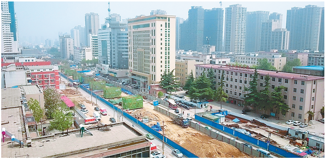
陇海路施工现场
