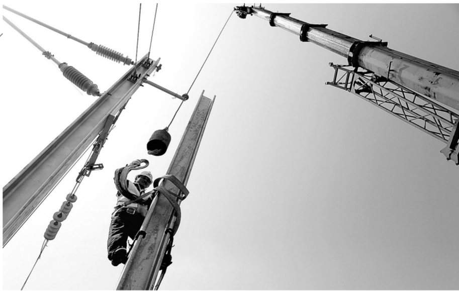
4月17日,技术人员在郑焦城际铁路施工现场的接触网杆上作业。当日,郑焦城际铁路启动牵引供电系统施工。按照计划,预计今年年底建成通车。郑焦城铁设计时速250公里。投入运营后,郑州至焦作半小时可到达。新华社记者 王颂摄
