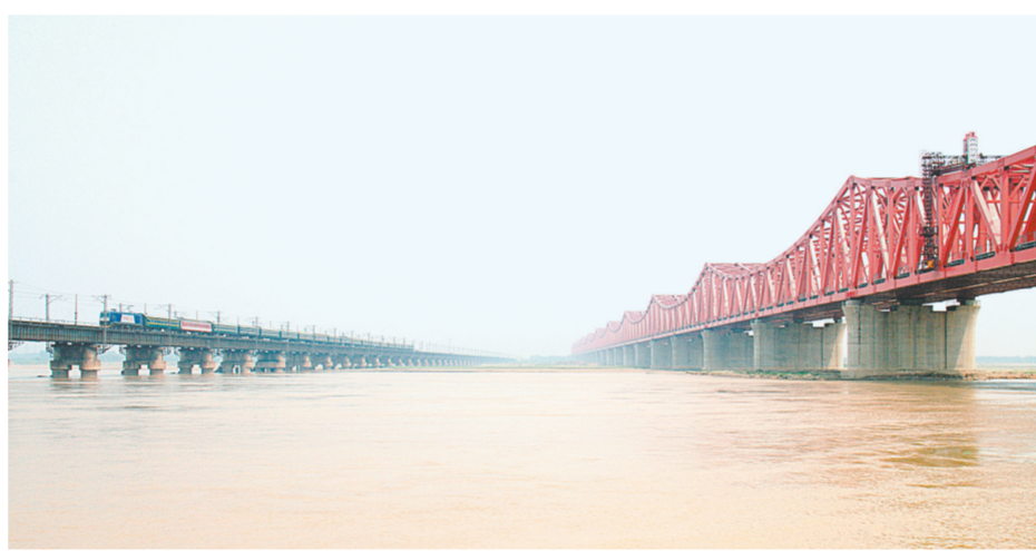
左侧是即将退役的京广铁路黄河大桥,右侧是新建的郑焦城际铁路黄河大桥。
