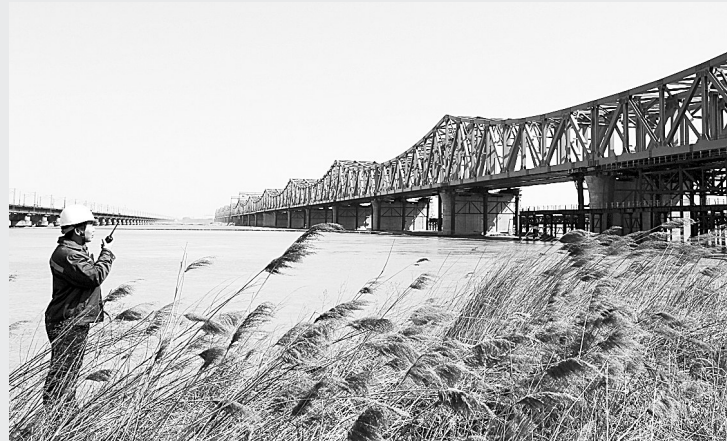
施工中的郑焦城际铁路黄河桥
