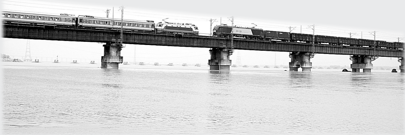
即将退役的京广铁路黄河大桥。
